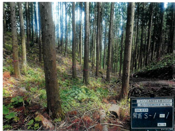
【森林整備施工後】
