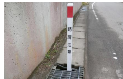
応急対応 （杭を立てて注意を促しています）
