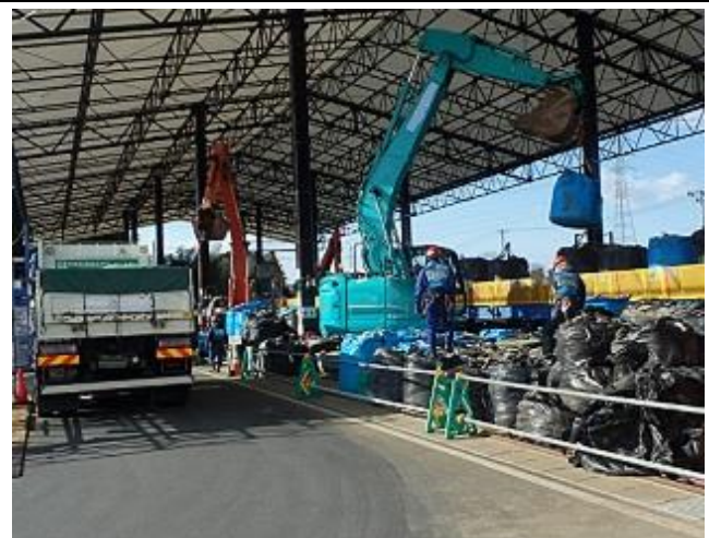
保管場荷下ろし状況確認
