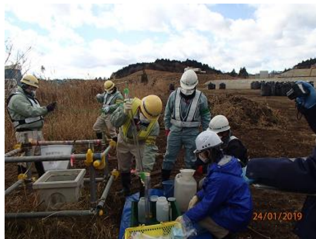
土壤貯蔵施設における地下水の測定
