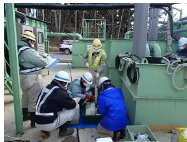
土壤貯蔵施設における処理水の測定
