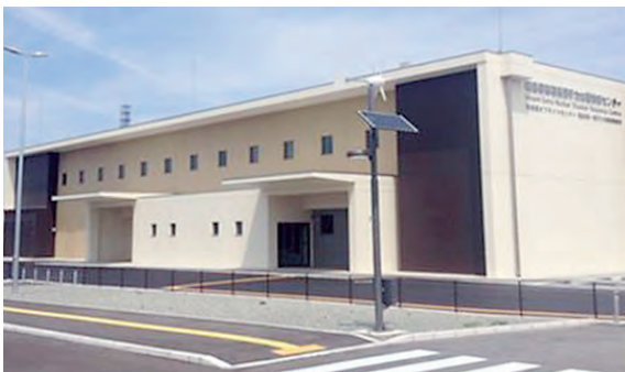
福島県南相馬オフサイトセンター (南相馬市原町区萱浜字巢掛場45-178)
