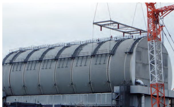
3号機燃料取り出し用カバー設置
