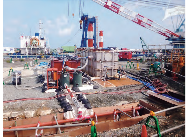
ウエルポイントによる汚染地下水汲み上げ
