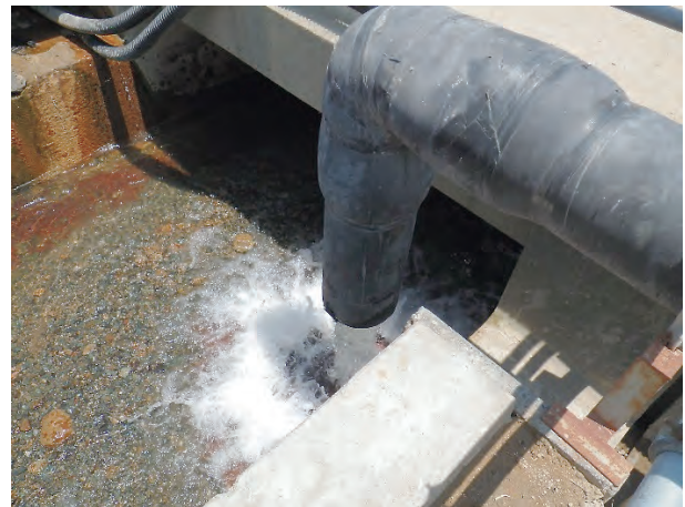
地下水バイパス排水状況
