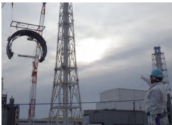
3号機燃料取り出し用カバー設置の状況確認
