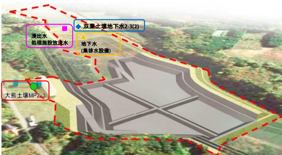
○大熊第2期3工区土壤貯蔵施設
