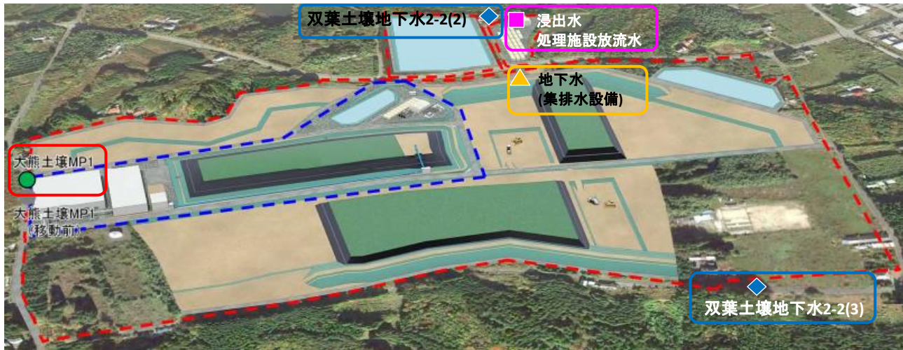
○大熊第2期2工区土壤貯蔵施設
