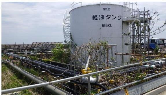
(写真5) No.2 軽油タンク (北西側から撮影)
