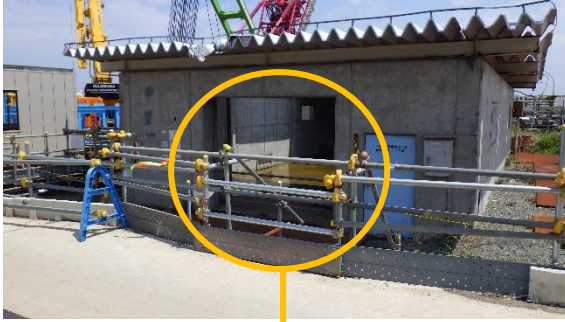
(写真3) 1～4号機発電機注入用窒素ガス ポンベ室 (西側から撮影)
