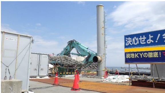
(写真7) ボイラー煙突 (南西側から撮影)
