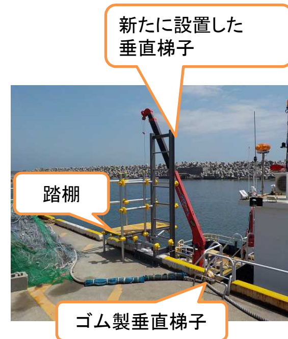
<垂直梯子と踏棚の設置状況> (6/3設置済み)
