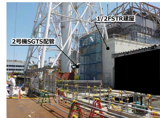
写真② クレーン設置予定場所の西側道路から排気筒方面を撮影 (SGTS配管がわずかに視認できるが霧囲気線量は変わらない)
