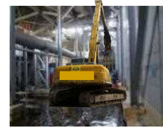
遠隔解体重機
