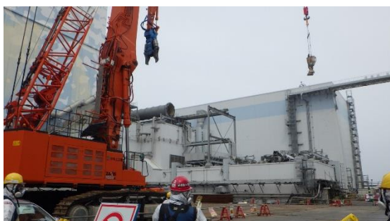
（写真1）飛散防止剤散布の様子1
