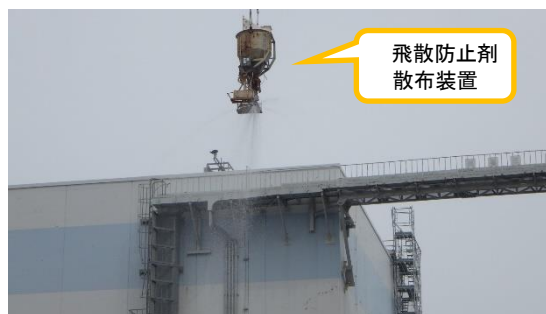
（写真2）飛散防止剤散布の様子2
