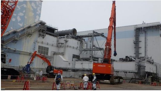
(写真3) 遠隔操作重機での解体の様子
