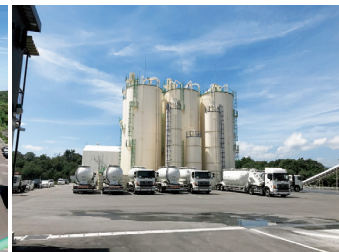
プラントサイロ全景
