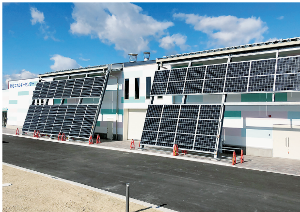
新地エネルギーセンター外観
