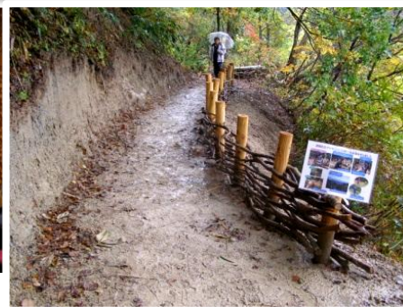
修繕された街道
