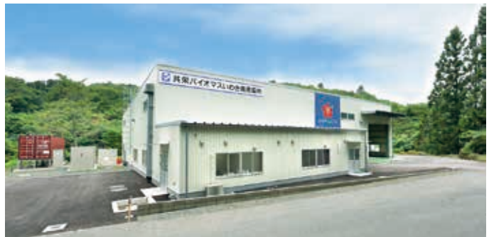
プラント全景写真
