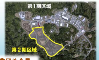
工業団地全景
