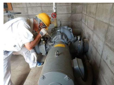
(用水ポンプの診断状況)
