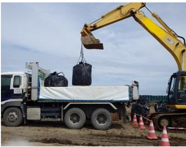
除去土壌等の積込作業
