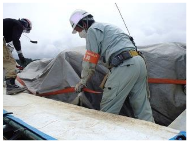
除去土壌等の飛散・防止対策
