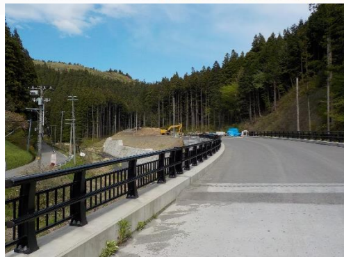
①(仮称)1号橋
