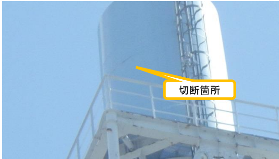
(写真4) 排気筒の状況
