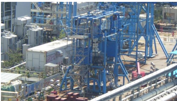
(写真3) 吊り降ろされた解体装置の状況 (11時頃)
