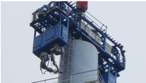
(写真2) 電線管クランプ回収作業の状況 (11時50分頃)
