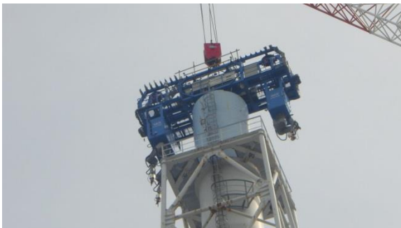
(写真5) 頂部に設置された解体装置の状況 (9時50分頃)
