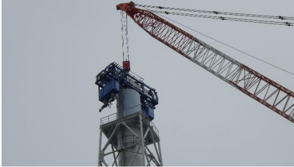
(写真1-2) 筒頂に設置された解体装置の状況 (11時15分頃)
