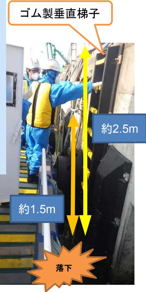
ゴム製垂直梯子の横バーと縦バーに手を掛け、次に横バーを離した際に縦バーに掛けていた手が滑り、落下した
