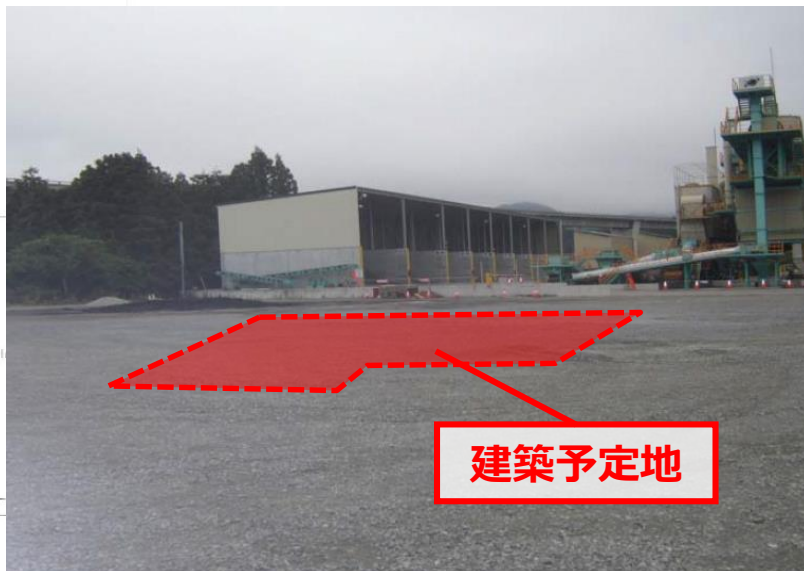
【写真②】建設予定地全景 (北西方向)
