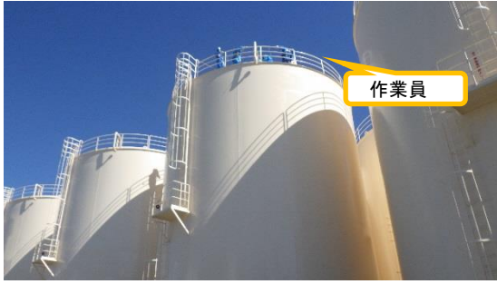
(写真1-1) 原因調査の様子
