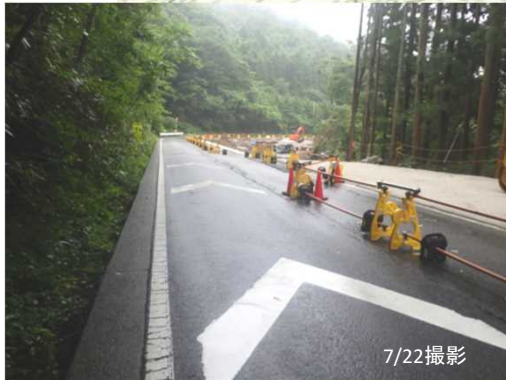
①工区伐採完了
