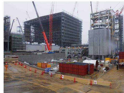
仮設焼却施設：機器据付
