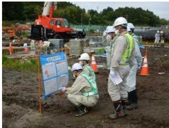
安全パトロールの様子2
