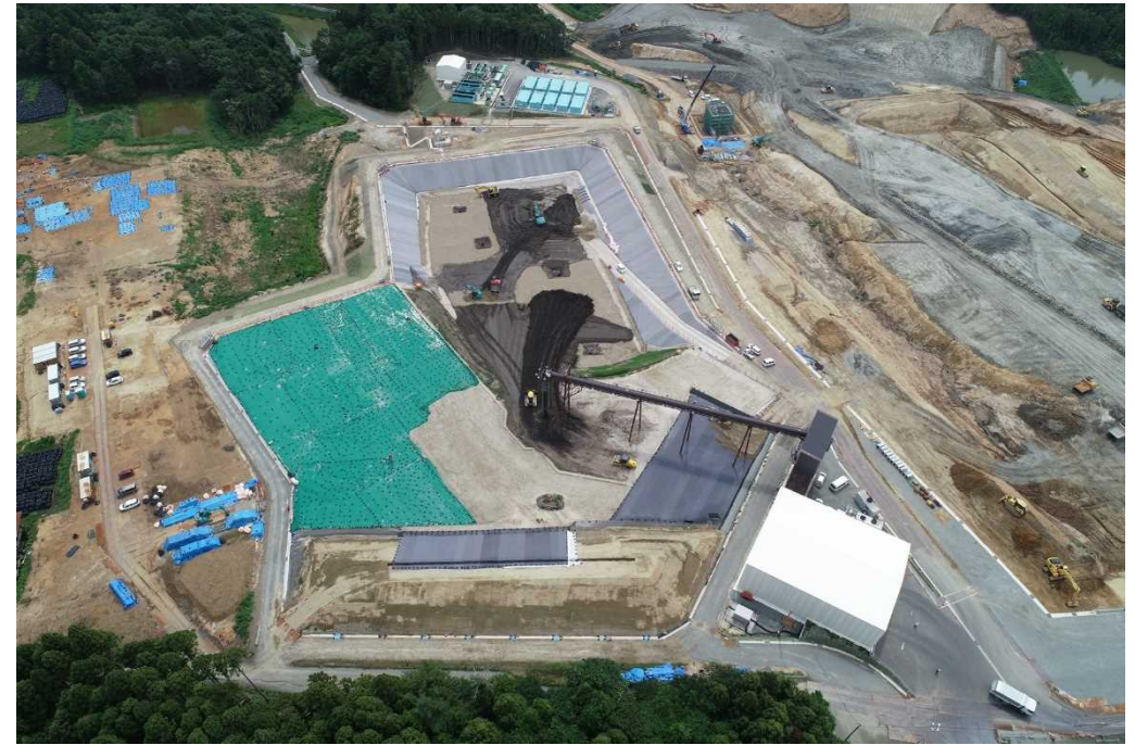
土壌貯蔵施設(西側)
