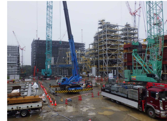
仮設灰処理施設：機器据付
