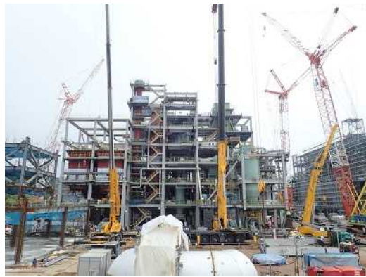
仮設焼却施設：機器据付
