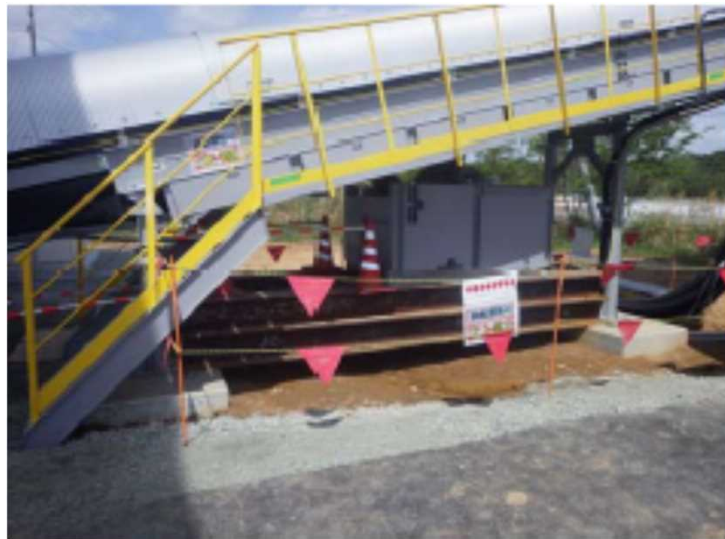
事故発生現場(対策実施後)
