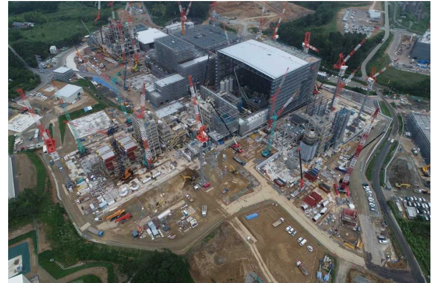
ヤード全景：7月19日現在
