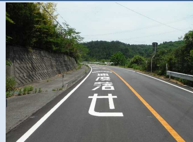
改良工事後の道路の様子(国道288号)
