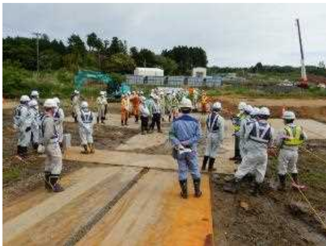
安全パトロールの様子1
