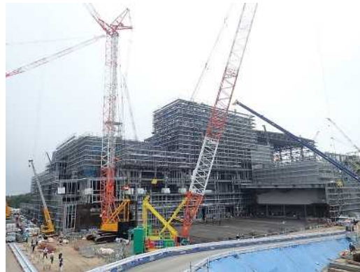
仮設灰処理施設：機器据付
