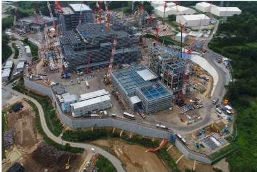
ヤード全景：7月30日現在
