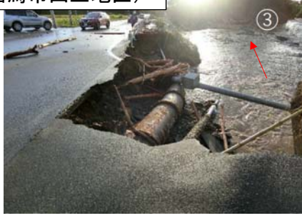
導水管破損（相馬市山上地区）
