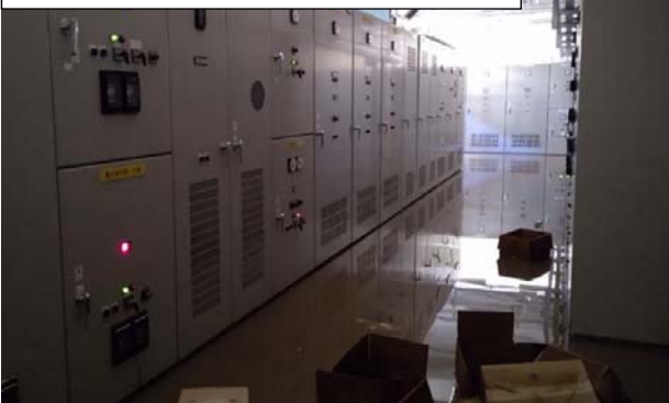
浸水状況①（いわき市平浄水場）
