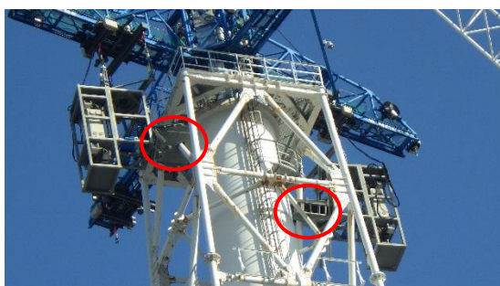
（写真4-2） 斜材切断装置拡大 2箇所の斜材をクランプで固定している 斜材の切断は切断装置内部のチップソーで押切りにより行う
