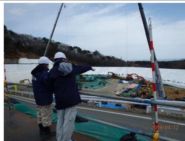
下流側埋立地の埋立状況の確認
