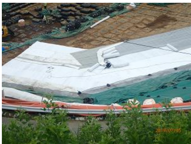
土壌層(不織布等)の施工状況の確認
