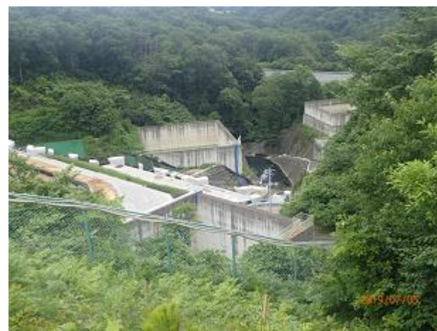
下流側土堰堤及び調整池等の確認
