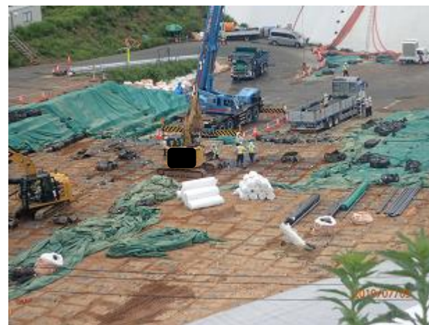
下流側埋立地の埋立状況の確認
