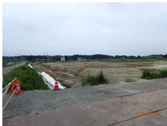
土壌貯蔵施設の設置状況の確認
