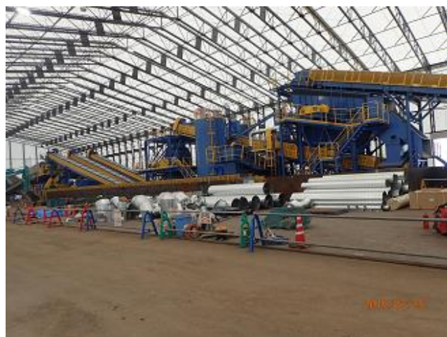
受入・分別施設の設置状況の確認
