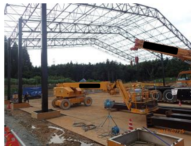
受入・分別施設の設置状況の確認
