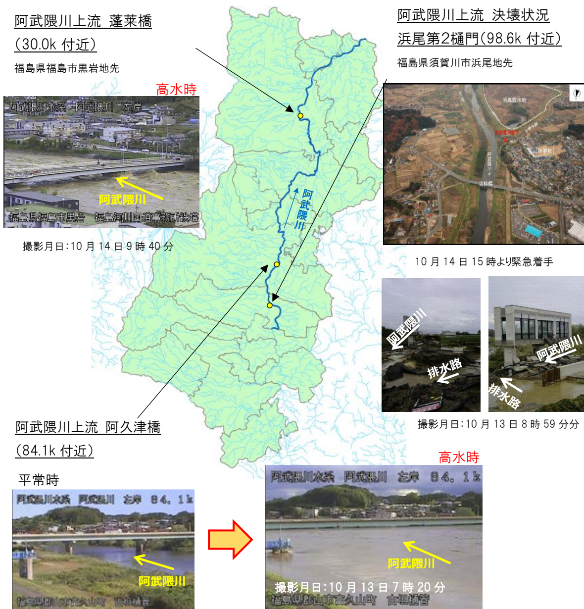
図1.3 阿武隈川流域の災害状況
