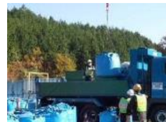
除去土壌等の車両積込状況
