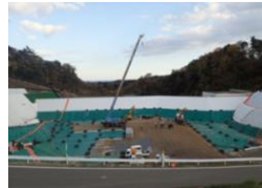
埋立処分施設の状況
