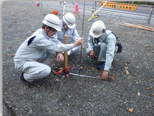
STEP2 測点の位置だしの様子。
