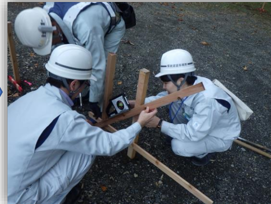
STEP3 水平器を利用し、切出し位置の高さ を出す。(丁張り掛け)
