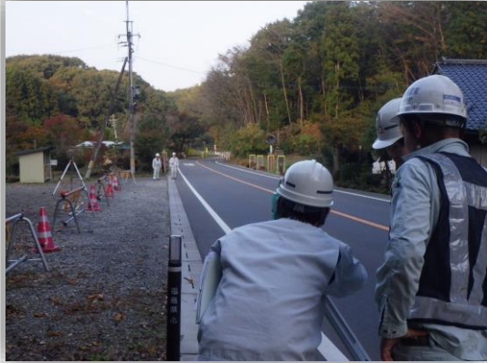
STEP1 トータルステーションを利用して 測量を行い測点の位置だしを行う。
