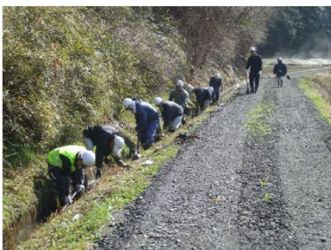
水路土砂上げ(棚倉町)
