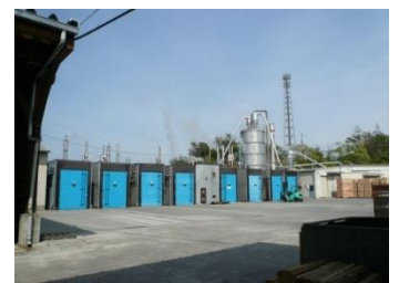
木材乾燥施設の整備（いわき市）
