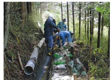
水路補修(棚倉町)
