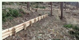
放射性物質拡散防止柵(丸太柵)の設置
