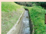
施工前の用水路
