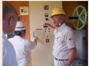
揚水機場の保守点検
