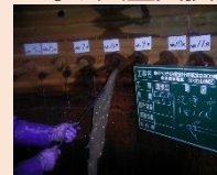
目詰まりした集水ボーリングの洗浄
