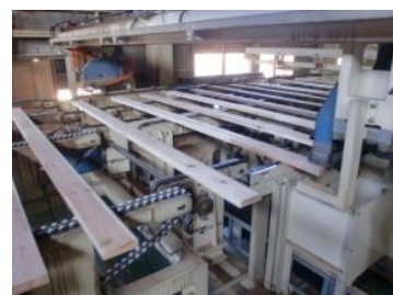
集成材製造施設の整備(埴町)
