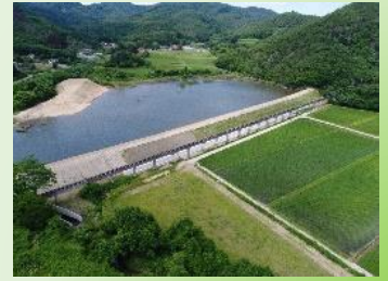
ため池全景(改修後)
