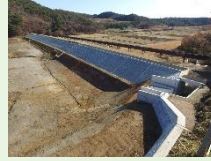
ため池堤体(改修後)
