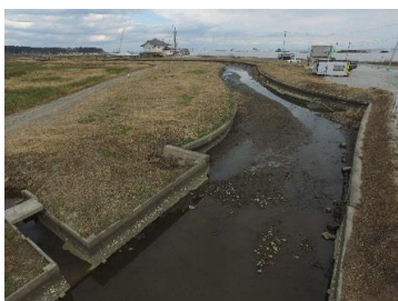
東日本大震災による治山施設（護岸工）の復旧（南相馬市）小沢地区
