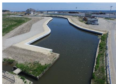
東日本大震災による治山施設（護岸工）の復旧（南相馬市）小沢地区
