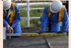
路面の点検状況
