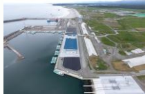
整備中の請戸漁港
