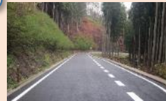
林内路網整備（林道整備） （永井川前線）
