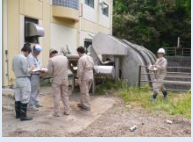
揚水機場の合同点検
