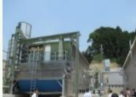
木質ペレット製造施設
