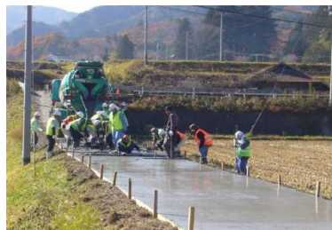
農道補修(棚倉町)
