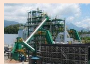
木質バイオマス発電施設
