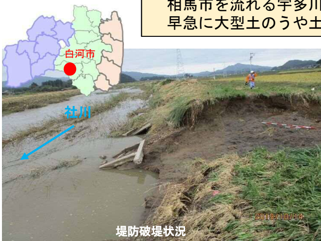
白河市を流れる社川において、河川の増水により堤体が流出し破堤。早急に大型土のうや土砂等により破堤箇所の応急復旧を実施した。
