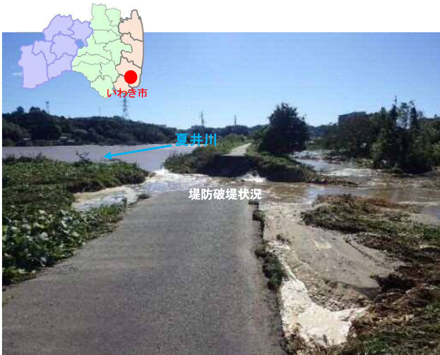
いわき市を流れる夏井川において、河川の増水により堤体が流出し破堤。早急に大型土のうや土砂等により破堤箇所の応急復旧を実施した。
