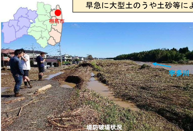
相馬市を流れる宇多川において、河川の増水により堤体が流出し破堤。早急に大型土のうや土砂等により破堤箇所の応急復旧を実施した。
