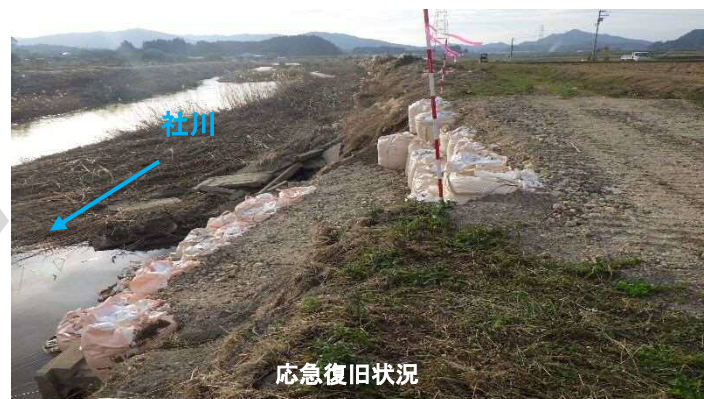
白河市を流れる社川において、河川の増水により堤体が流出し破堤。早急に大型土のうや土砂等により破堤箇所の応急復旧を実施した。
