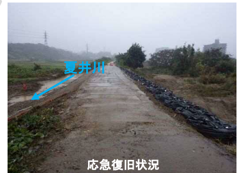
いわき市を流れる夏井川において、河川の増水により堤体が流出し破堤。早急に大型土のうや土砂等により破堤箇所の応急復旧を実施した。
