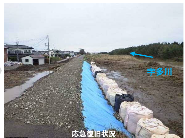
相馬市を流れる宇多川において、河川の増水により堤体が流出し破堤。早急に大型土のうや土砂等により破堤箇所の応急復旧を実施した。
