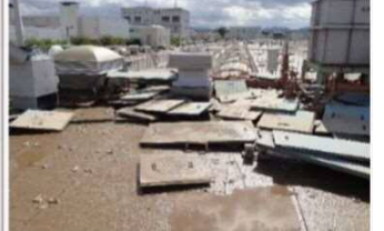
水処理施設被災状況
