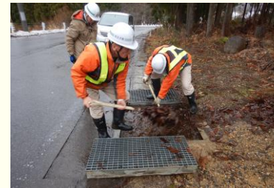
集水柵の詰まり改善
