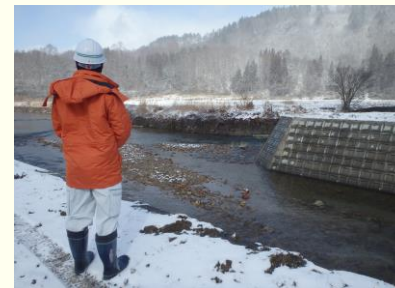
河川パトロール状況
