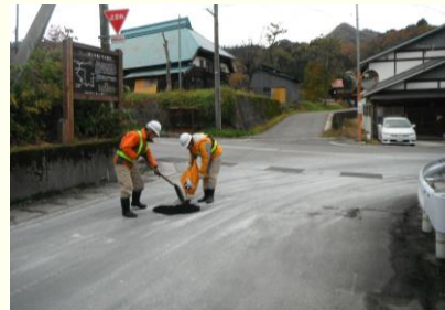
道路修繕作業(穴埋め)
