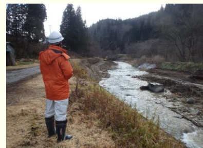
河川工事状況の巡視
