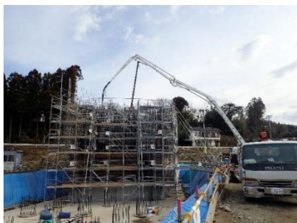
橋梁工事の施工状況 (コンクリート打設)
