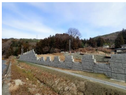
擁壁工事の施工状況 (壁面パネル設置)
