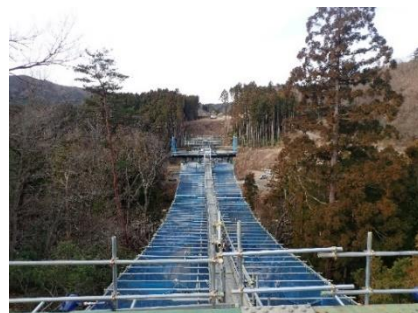
橋梁工事の施工状況 (桁架設に先立つ仮設)
