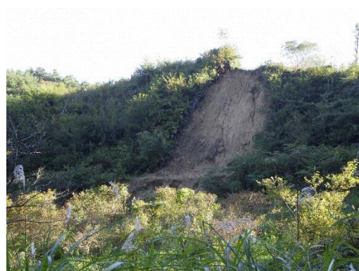
川内村(下川内字糠塚地内)の土砂災害の状況
