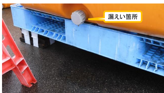
(写真1-2) ローリータンク下部の拡大写真
