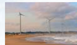
万葉の里風力発電所（南相馬市）
