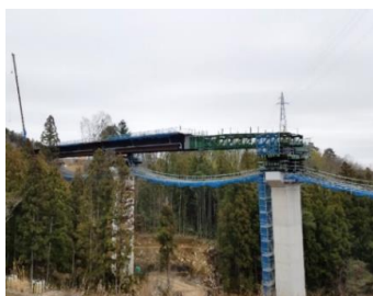
(送り出し工法状況)
