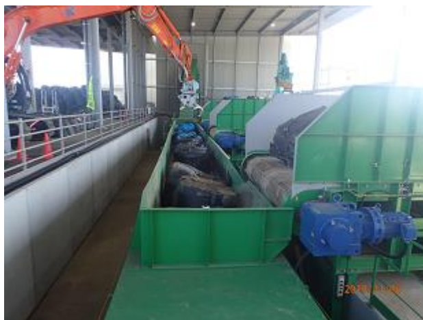
受入・分別施設の稼働状況の確認
