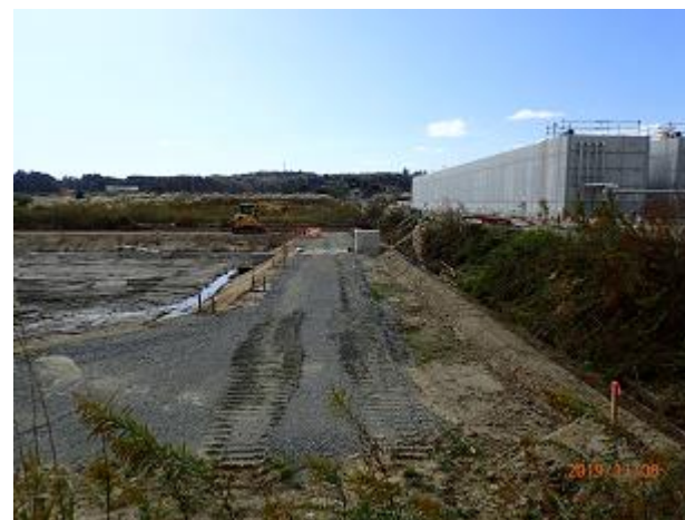
調整池の復旧状況の確認
