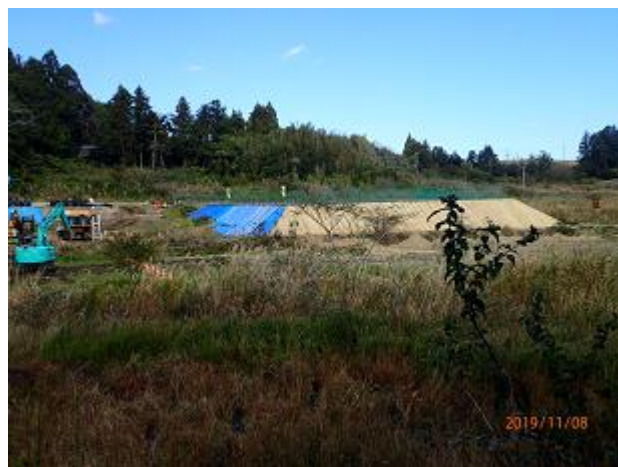
保管場の復旧状況の確認
