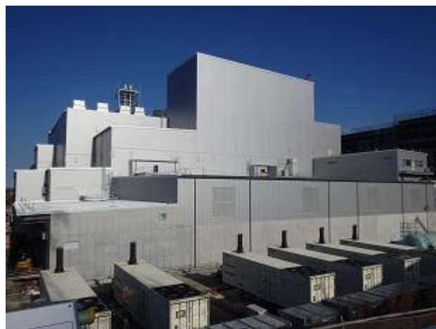
仮設灰処理施設の設置状況の確認
