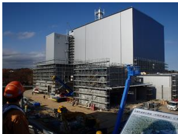
仮設焼却施設の設置状況の確認
