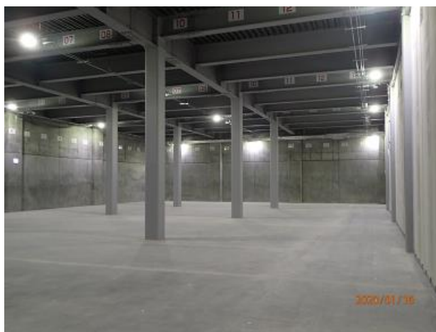
廃棄物貯蔵施設の設置状況の確認
