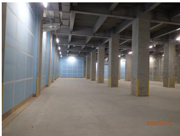
廃棄物貯蔵施設の設置状況の確認
