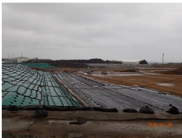
土壌貯蔵施設の稼働状況の確認
