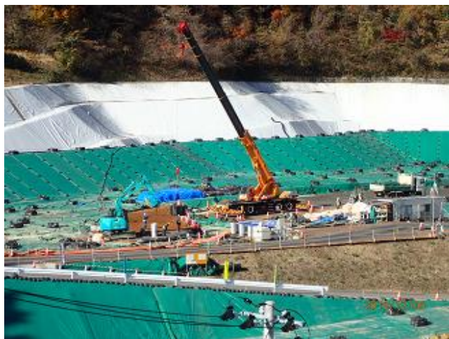
上流側埋立地の埋立状況の確認
