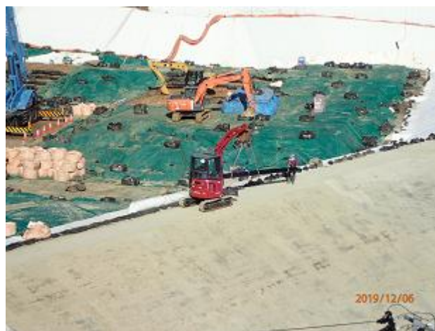
土堰堤の築堤状況の確認
