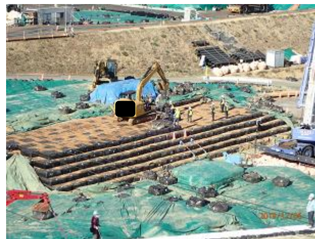
下流側埋立地の埋立状況の確認
