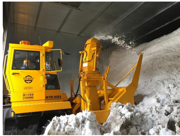
ロータリー車で雪室庫内へ雪入れ
