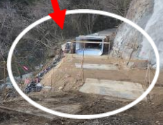
水路工事状況
