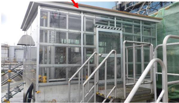
(写真1-2) ポンプ室外観
