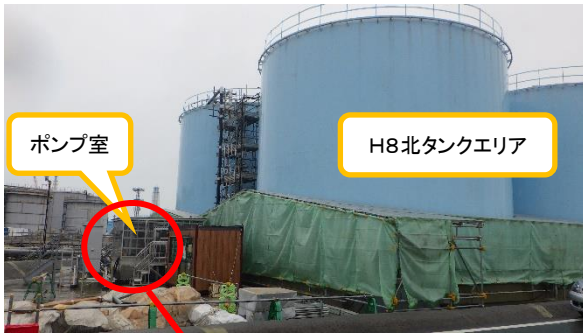
(写真1-1) H8北タンクエリア外観 (西側から撮影)
