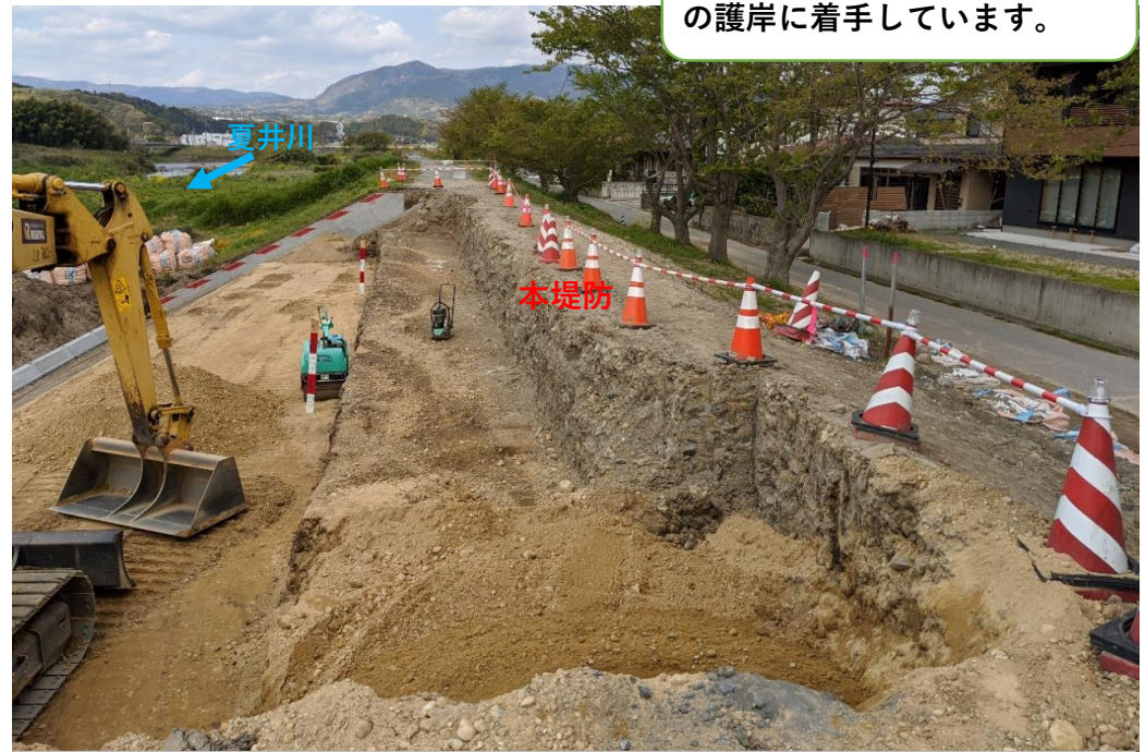
堤防護岸 コンクリート張ブロック施工中 施工状況（令和2年4月27日）
