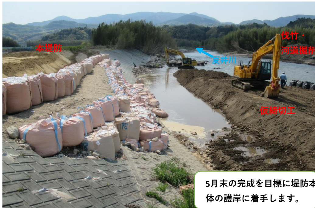
仮堤防設置完了、堤防盛土施工中
